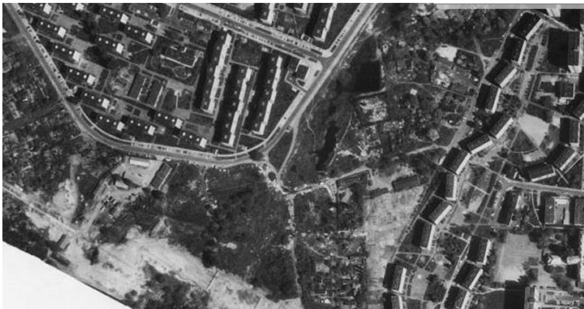
Trwają prace pod budowę wielkiej rury
