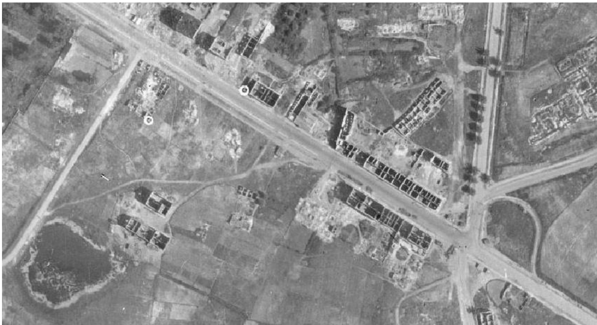
Zniszczone domy na Powązkowskiej przy skrzyżowaniu z Elbląską
