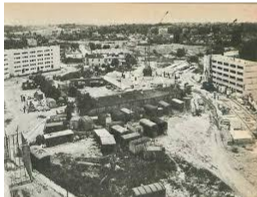
Budowa osiedla Zatrassie
